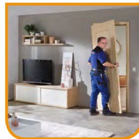
Ausbau und umweltgerechte Entsorgung
